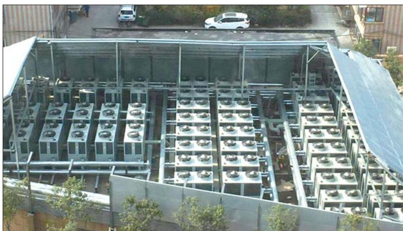
小区供暖设备外面正在加一层隔音板。
