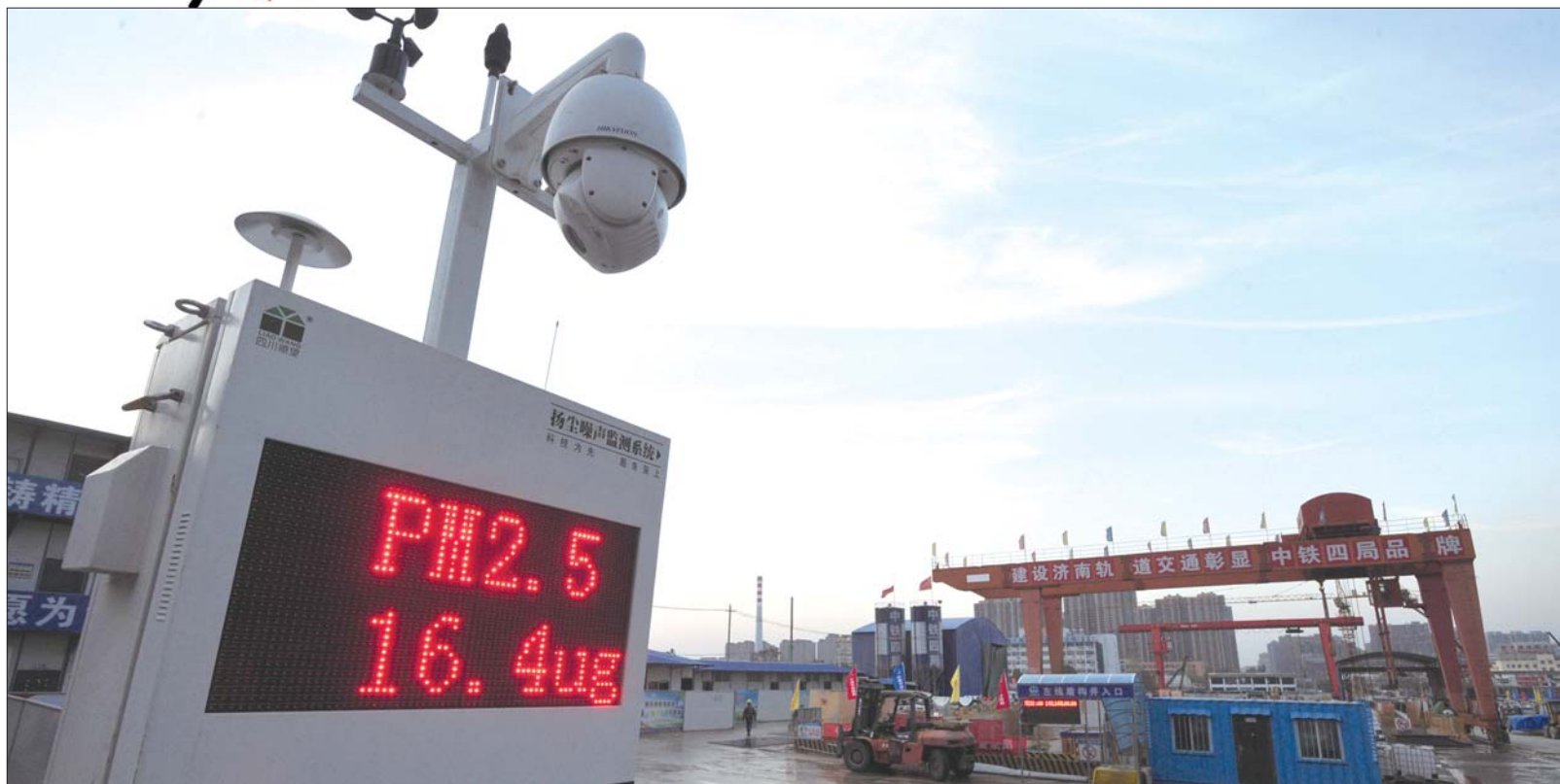
济南轨道R3线中铁四局施工现场,检测系统实时显示施工现场风向、噪音、PM10、PM2.5等指标。(资料片) 本报记者 张中 摄
