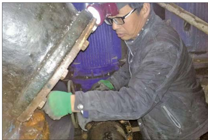
为保障正常供暖,工作人员加班加点维修设备。 本报记者 李云云 摄
