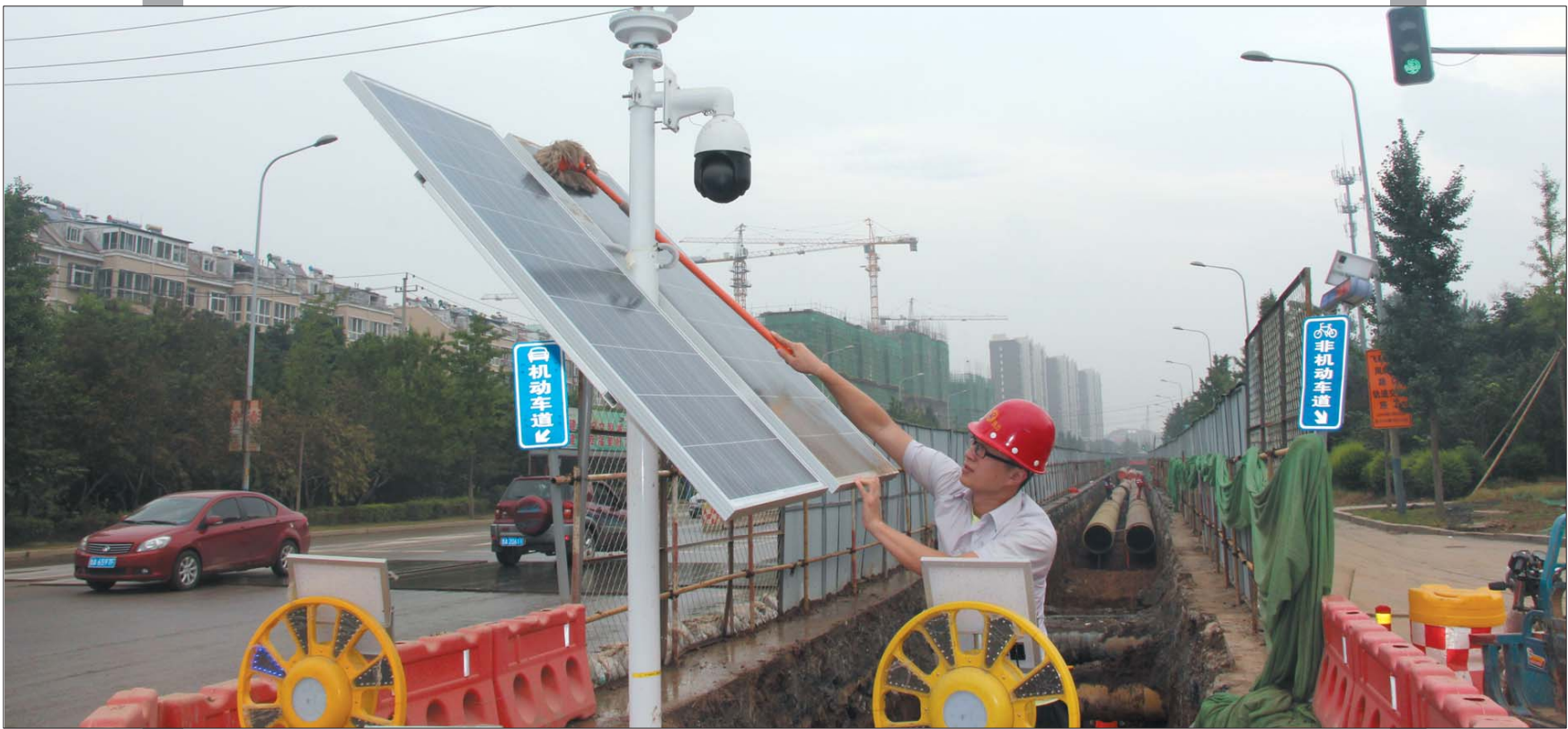
济南热力集团率先在全市推出风光互补道路施工云监控系统,可利用手机APP24小时360度监控扬尘治理。(资料片)
