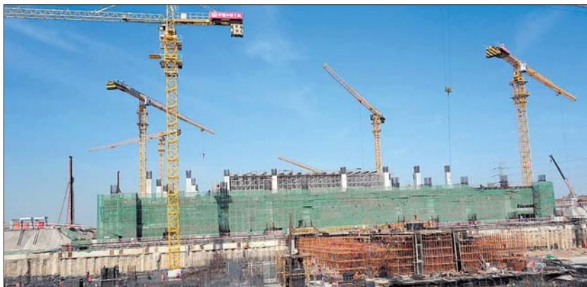
建设中的新东站。 本报记者 王鸿光 摄
