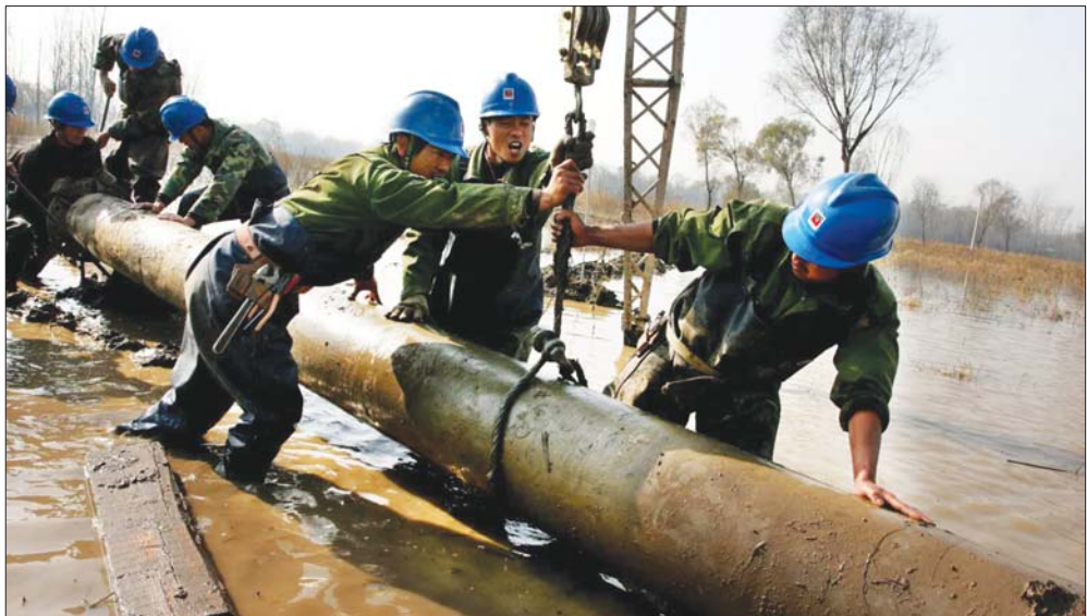
当年供电铁军架线施工的场景(资料图)。
