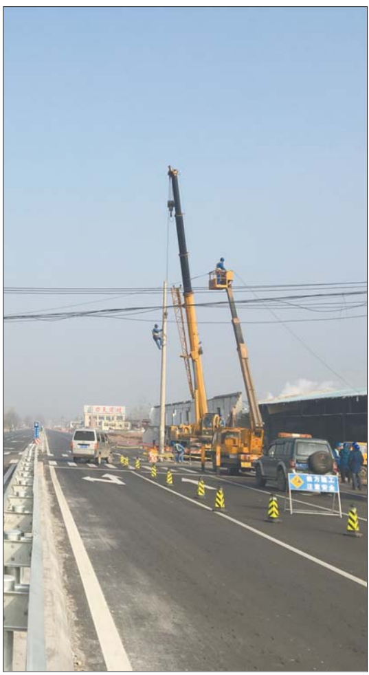
国道104黄河北段东西两侧围栏已经建好,中间为隔离带,施工人员正在拔除线杆。 本报记者 刘飞跃 摄
