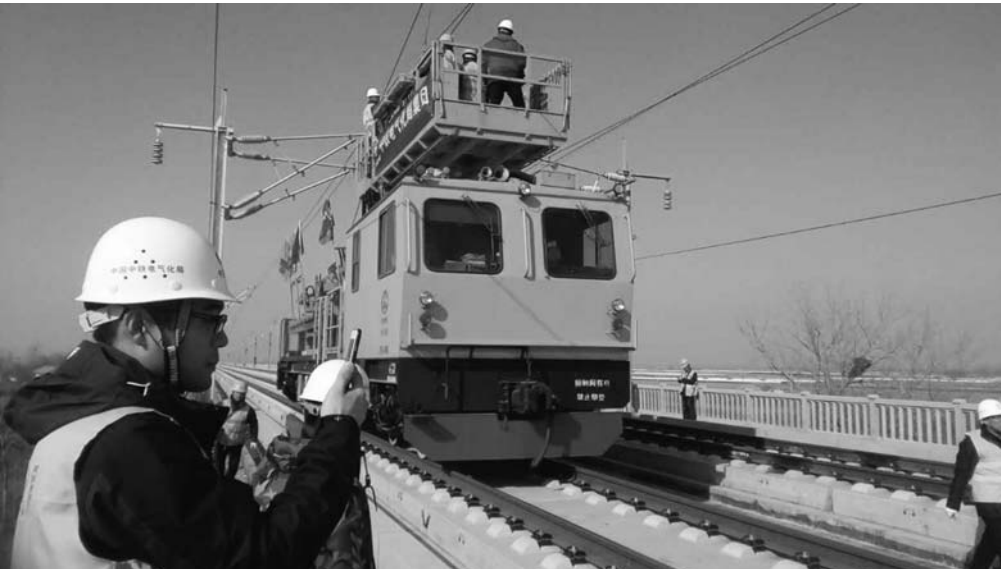
11月21日上午，由中铁电气化局集团承建的新建济南至青岛高速铁路第一条接触网导线在临淄北至青州北区间下行Ⅱ-13锚段成功架设，标志着济青高铁站后四电施工正式进入接触网导线定位调整阶段。
