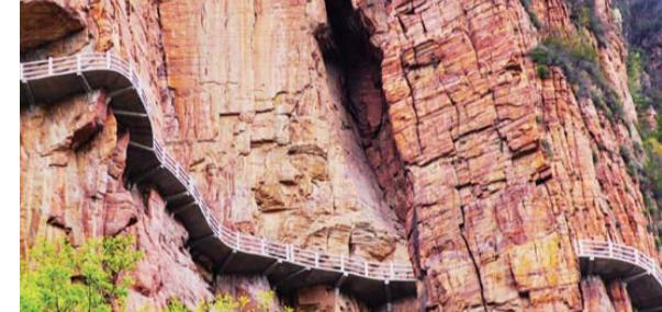
化玻璃栈道,全长266米,宽2米,采用30毫米厚的双层夹胶玻璃精心打造,每平方可承重350kg,是目前国内最长、唯一、最大的U字型夜景亮化悬空玻璃栈道。
