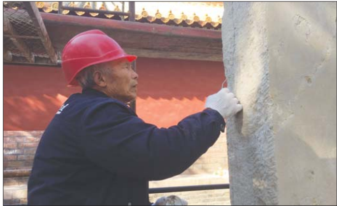
工作人员正拿着“小抹子”蘸着凝固膏体进行填补。
