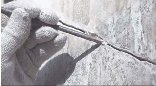
工人往碑刻的裂缝中一点点地涂抹凝固膏体。
