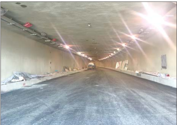
25日下午,玉函路隧道东线隧道口已经铺完粗粒沥青。 本报记者 刘飞跃 摄
