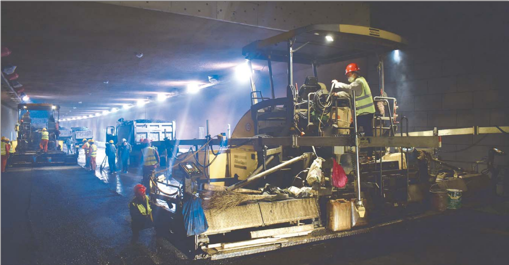
11月25日凌晨两点半,玉函路隧道东线路面开始摊铺沥青。
