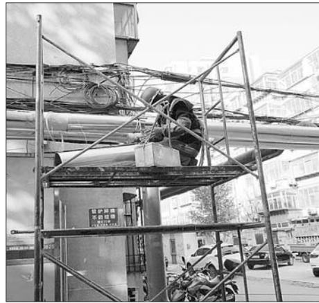
工作人员在进行管网收尾工作。记者 蒋龙龙 摄
