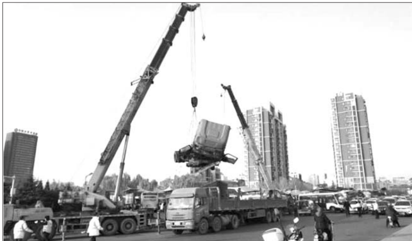
两辆吊车将车头吊起。
