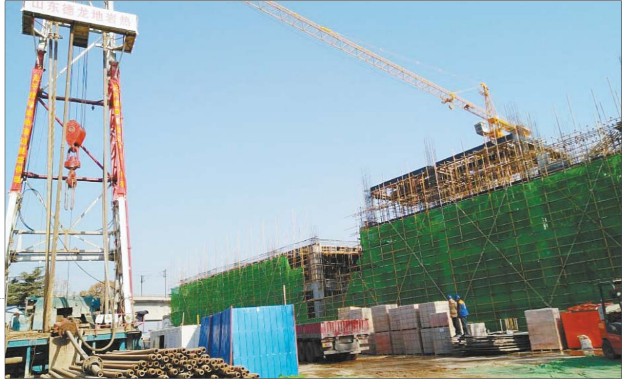
济钢新村正在建设的能源站。 本报记者 蒋龙龙 摄
