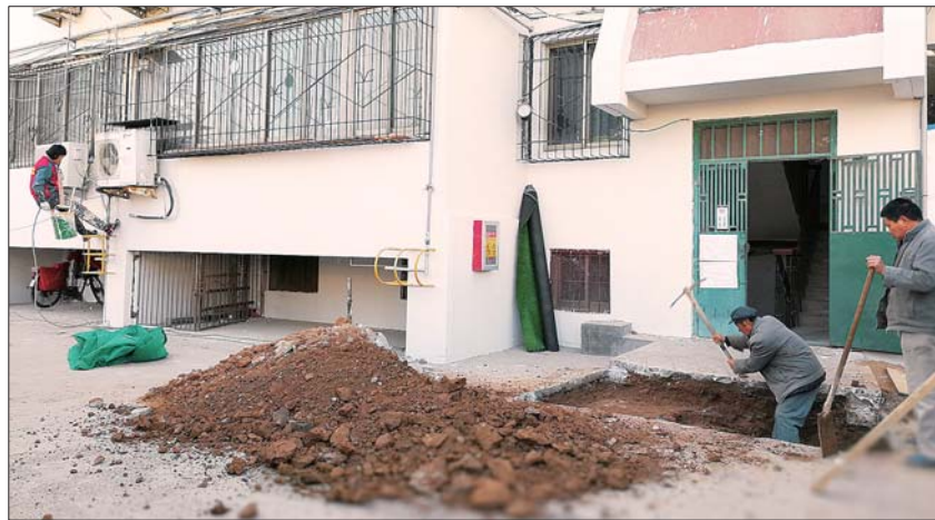
玉函路某小区内,老楼前已经开挖电梯井道基坑。 本报记者 魏新丽 摄
