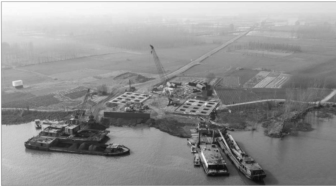
枣菏高速跨南四湖特大桥施工现场,正在进行桩基的施工。
