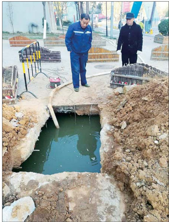
阳光100国际新城小区中,排污管道在进行维修。(采访对象供图)
