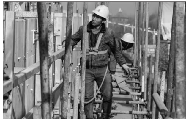
孔孟旅游快线示范线龙山站正在紧张建设中。
