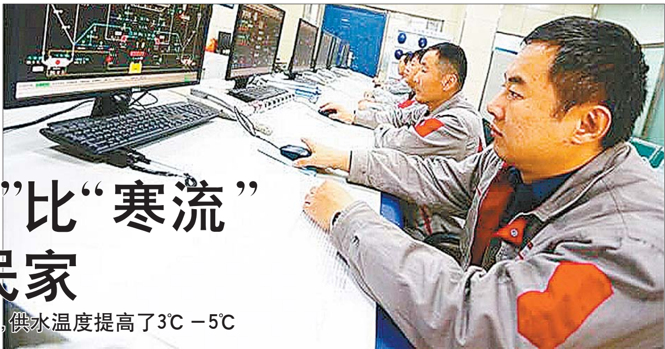
济南热电公司工作人员正在实时监控,准备提升供暖管网温度。 本报记者 蒋龙龙 摄
