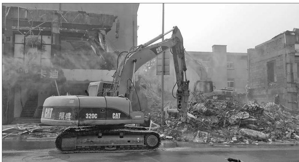
4月24日,城管部门拆除山师东路西侧的违建门头房。 本报记者 康鹏 摄
