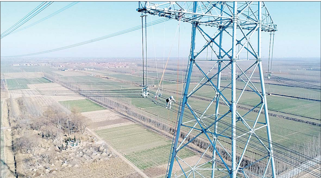
19日11点10分,济南章丘的1000千伏泉乐Ⅱ线83号铁塔上,山东特高压首次完成带电消缺,标志着国网山东省电力公司在电网运维检修领域达到世界领先水平。与停电消缺相比,本次带电作业减少停电2个小时,在“迎峰度冬”的关键时期,增供电量95万千瓦时。 见习记者 王瑞超 通讯员 郭轶敏 杨森 摄
