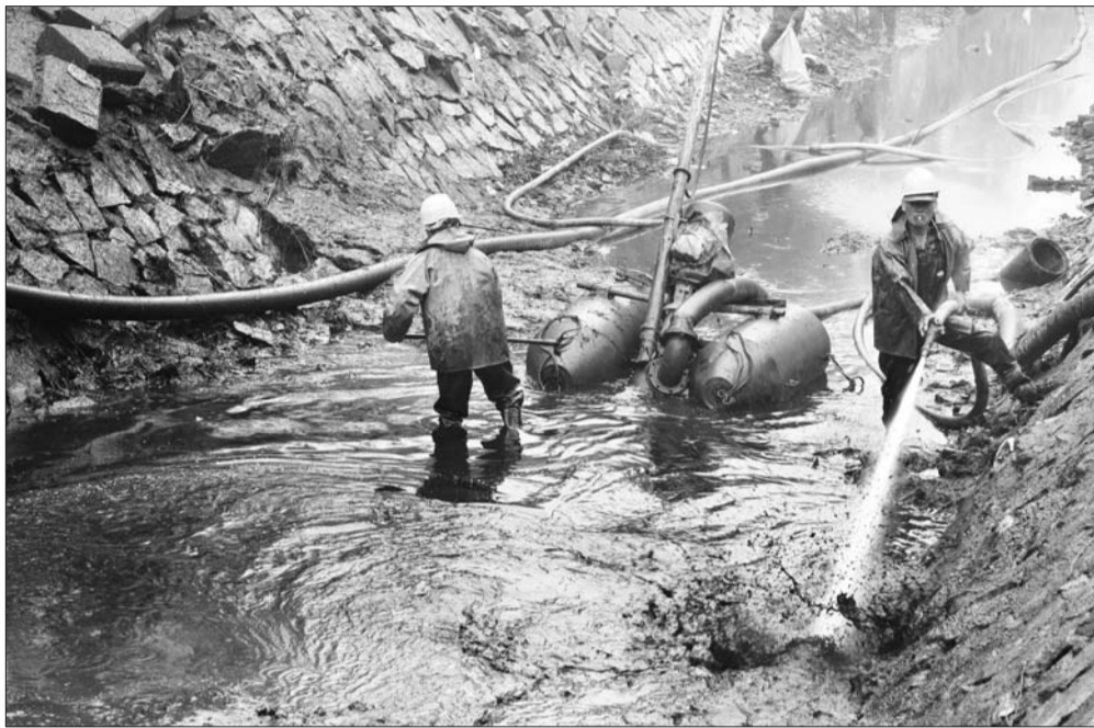
城区一处河道排水清淤现场(资料图)。
