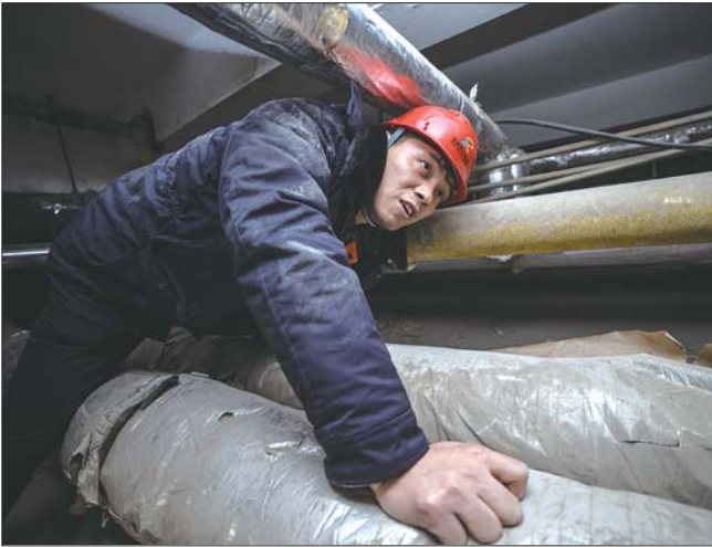
济南热力集团供暖管家正在检查小区内供热管网。
