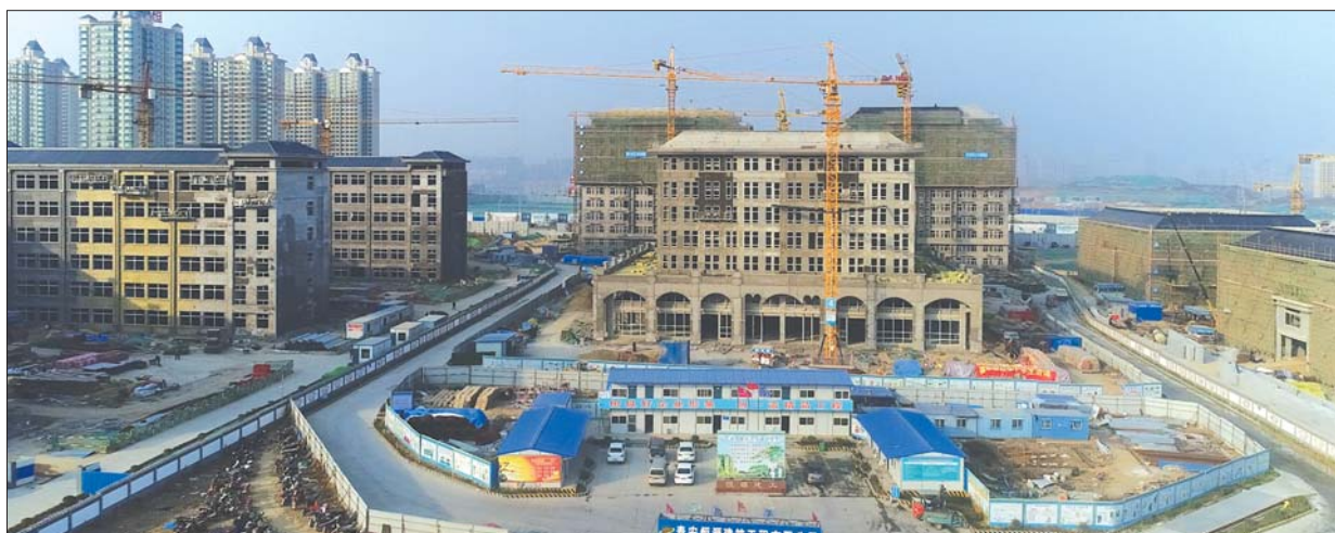
正在建设的高级中学。
