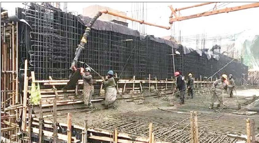
正在建设中的华山水质净化厂建设项目。(资料片)
