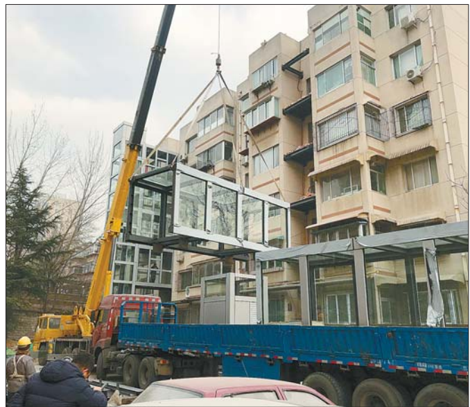
第二部电梯吊装现场。本报记者 王杰 摄
