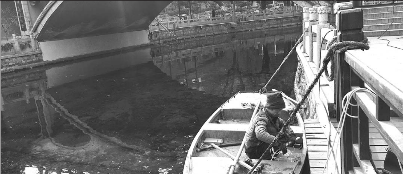
施工人员正在将水下点灯的线路接到线槽里。
