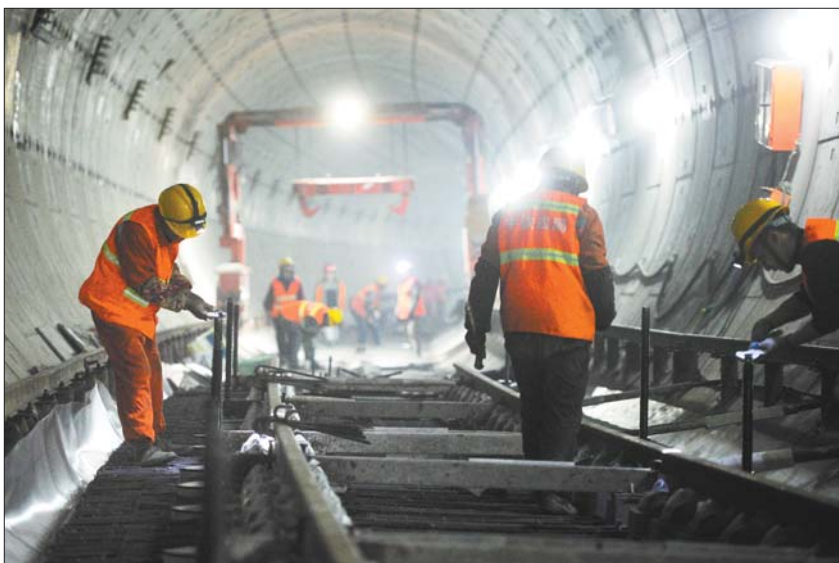
济南R1线地下隧道钢轨铺设。(资料片)
