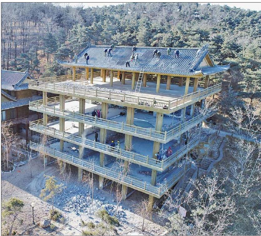
由于保护周围林木,并减少建设者的损失,拆违人员在楼顶上进行手工拆除。
