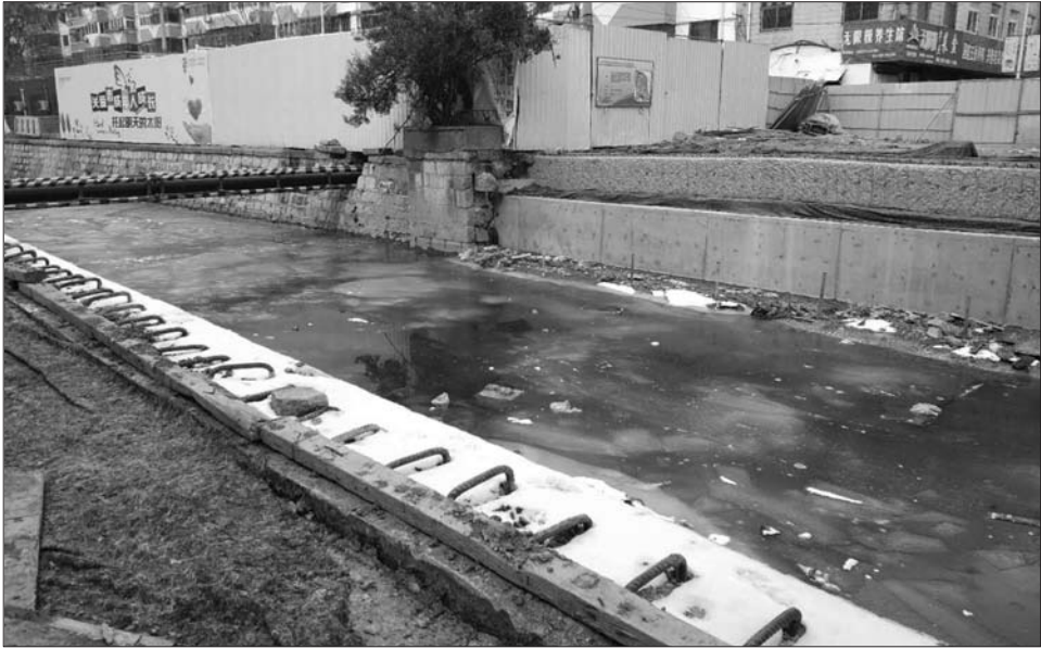
兴隆桥桥面已被拆除。 本报记者 孙璇 摄
