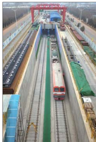
▼R1线玉符河站入地点轨排铺设完毕。 照片均由济南轨道交通集团提供
