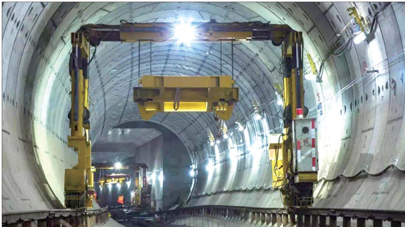
◀R1线地下段在进行铺轨作业。
