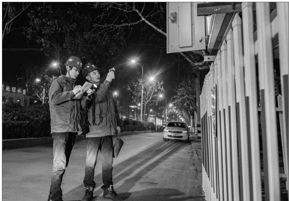
供电工作人员正在对10千伏配网巡视测温。 本报通讯员 王者东 摄
