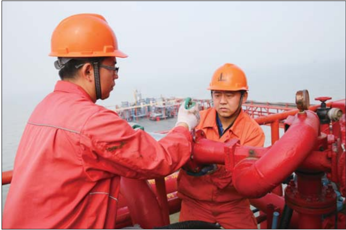
平台员工正在维修保养消防设施。
