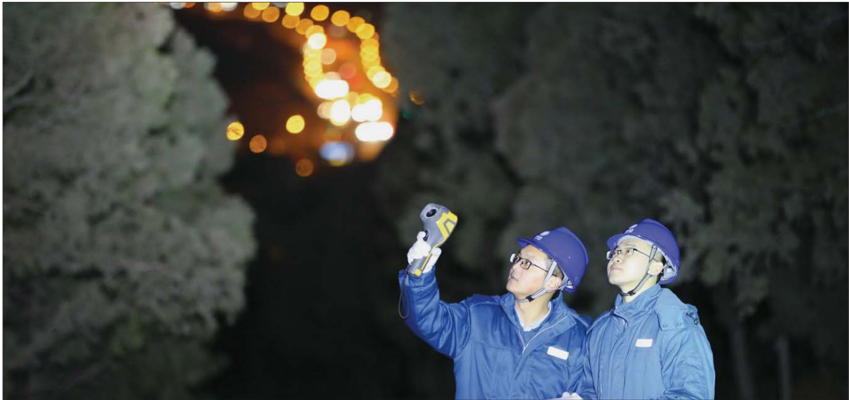
小年夜,济南供电公司运检部员工开展设备特巡,保障春节期间电网安全稳定运行。本报记者 王皇 通讯员 刘洪金 摄
