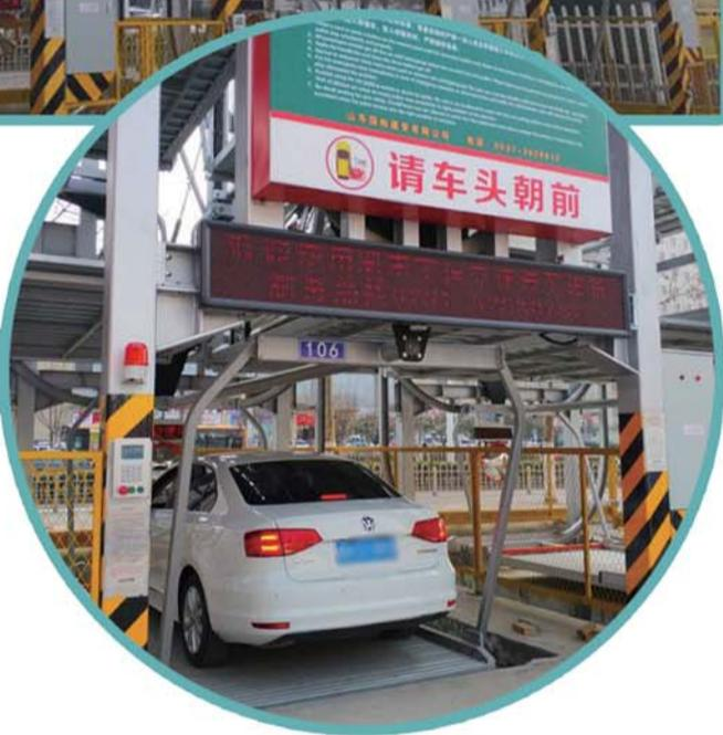
日前,任城区又有一处智慧停车场开始启用。这处位于金宇家居的垂直循环式立体停车场共3层,可同时停放18辆汽车,自23日试运营以来,该智慧停车场赢得不少车主的认可。同时,也有效缓解了此处停车位紧张的难题。
