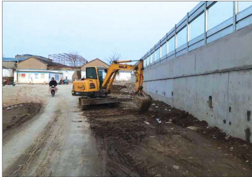
路面正在施工处理。
