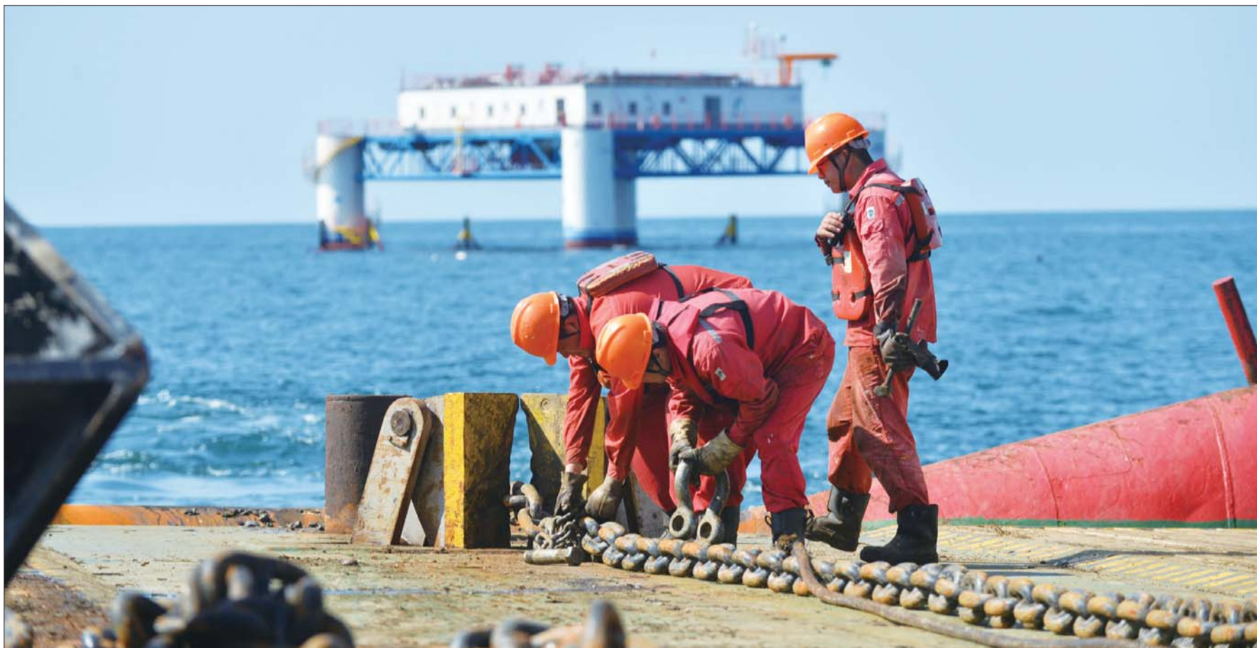
海洋石油船舶中心对半潜式海洋牧场进行精就位作业。
