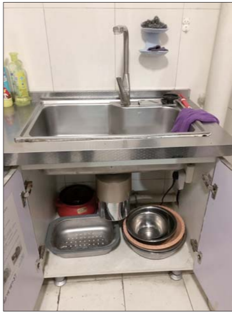
厨房水槽的排水口处,装着一台俗称“大胃王”的家庭厨余粉碎机。
