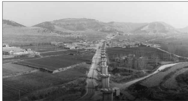
鲁南高铁曲阜段线下工程基本结束,沿线墩身很是壮观。
