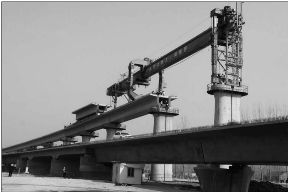
鲁南高铁曲阜段已经陆续展开线上箱梁架设等施工。
