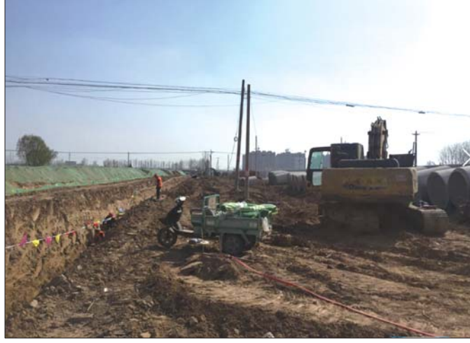
大学路施工现场。
