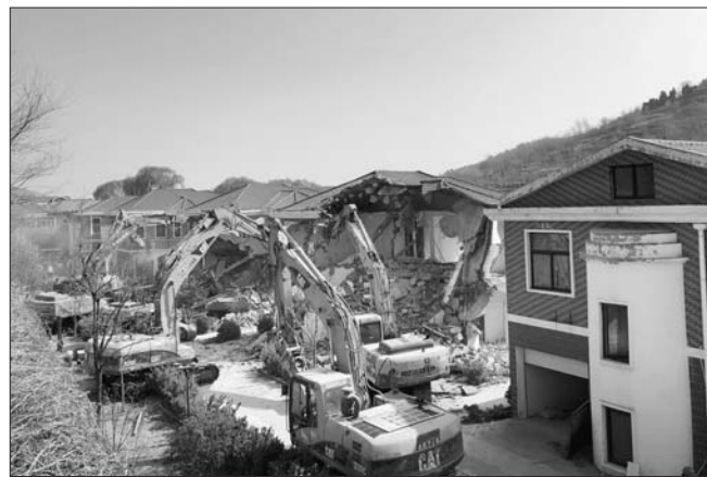
建设精美的别墅在挖掘机的轰鸣声中倒塌。
