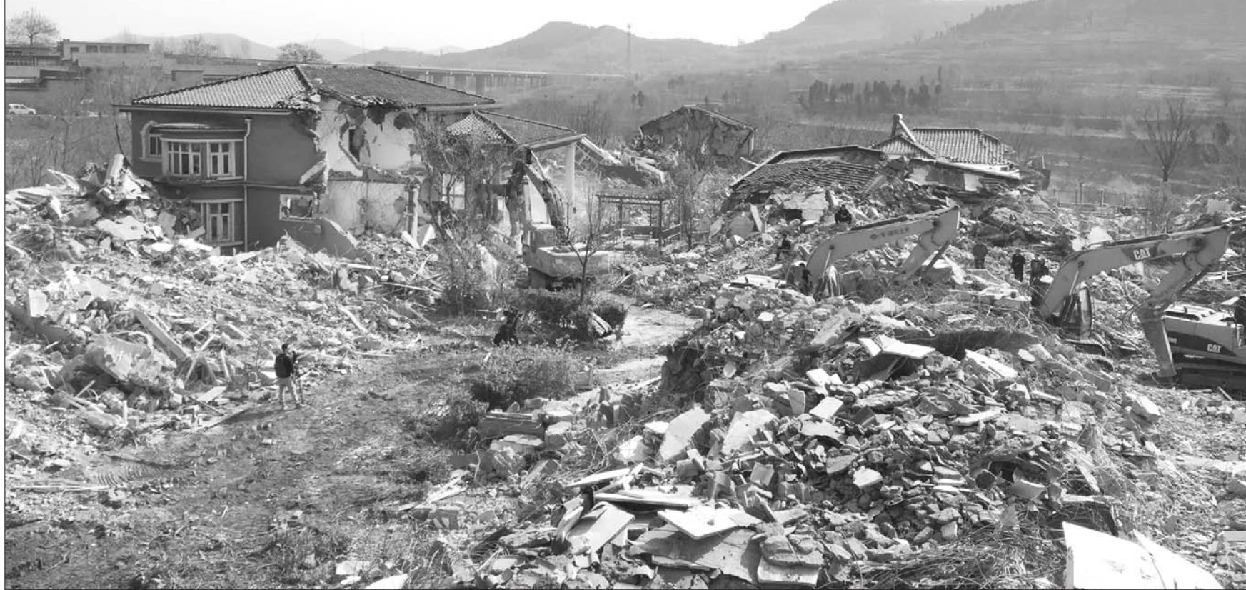
拆除现场,一栋栋“野别墅”被夷为平地。
