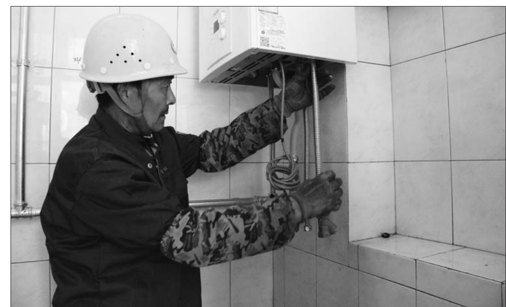
施工人员正在安装燃气壁挂炉。 本报记者 孙璇 摄
