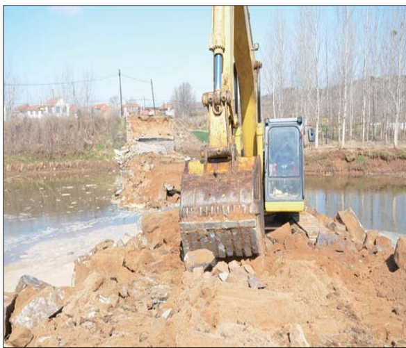
大台桥施工现场。牛燕华 摄
