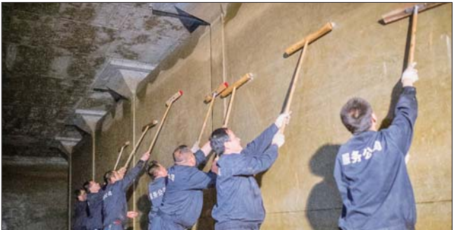
在金鸡岭加压站内,水务人员正在对清水池进行反复清洗。
