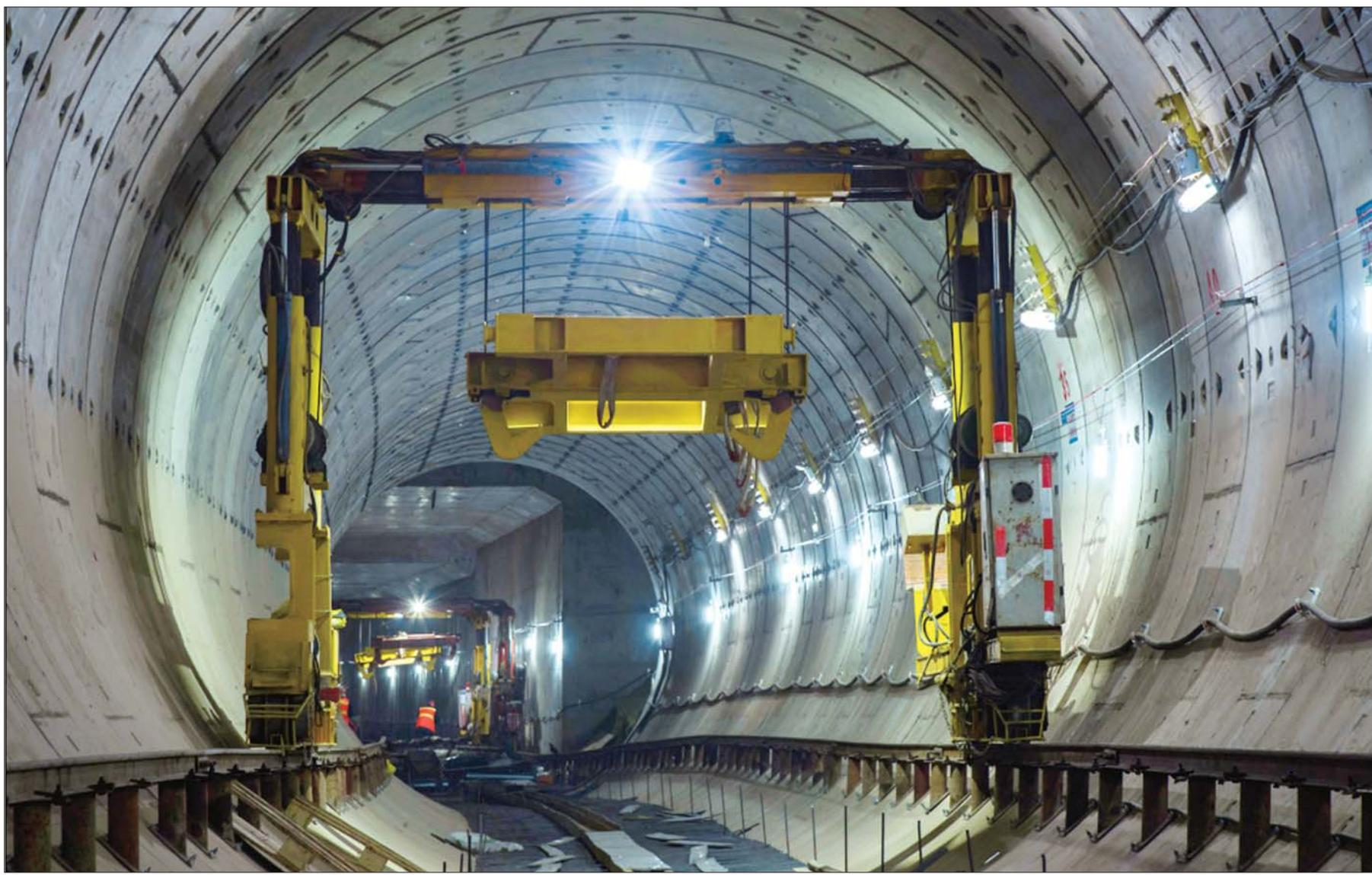
4月24日,济南首条地铁R1线实现全线“洞通”,地下段进入轨道铺设阶段。R1线是纵贯西部新城南北的一条主干线,施工中成功解决盾构机穿越富水高强灰岩岩溶区等世界性难题。小图:全线“洞通”目标的实现,标志着主体工程圆满完成。 本报记者 王媛 实习生 乔彤彤 摄
