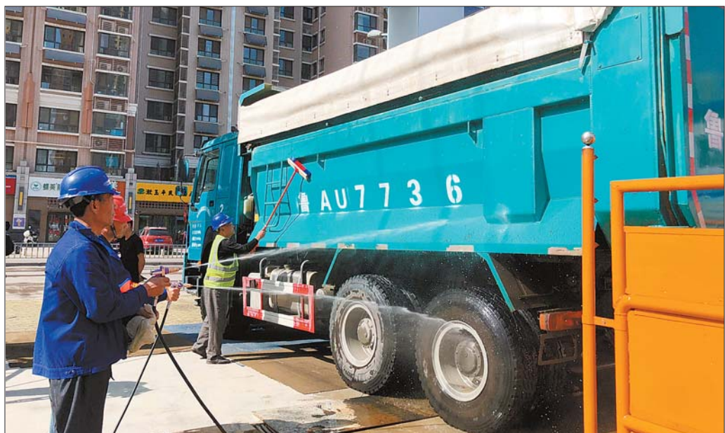
在天桥区宝华中学工地,渣土车出门前要经过“三步冲洗”。 本报记者 张阿凤 摄
