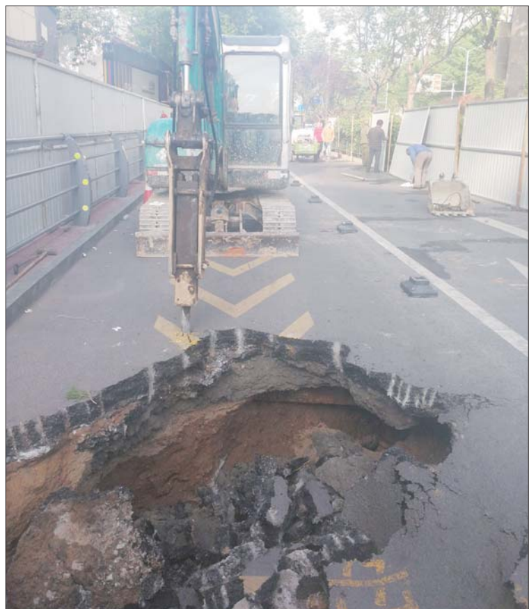
24日下午四五时,带钻头的挖掘机到现场开挖塌陷处周边路面。本报记者 王皇 摄
