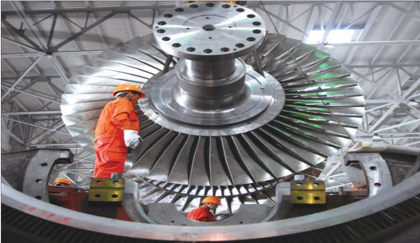
《汽轮机安装》 朱连生 华能威海电厂六号机组汽轮机转子安装现场 2010年7月12日
