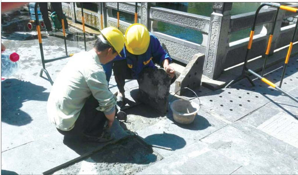
3日下午,施工人员对松动的石板进行整修。
