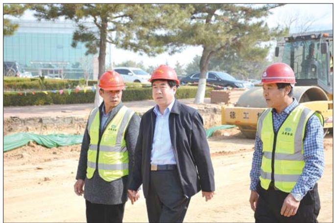
许丰财(中)在胜利街提升改造工程现场。(孙轶琰 摄)
